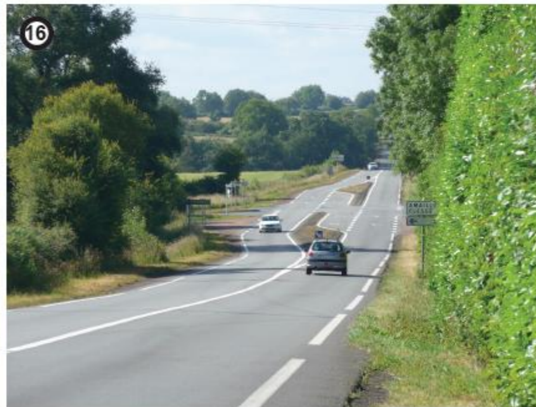
15 Vue depuis la D327 vers l'intersection avec la N149 où la modification de l'intersection est envisagée.
